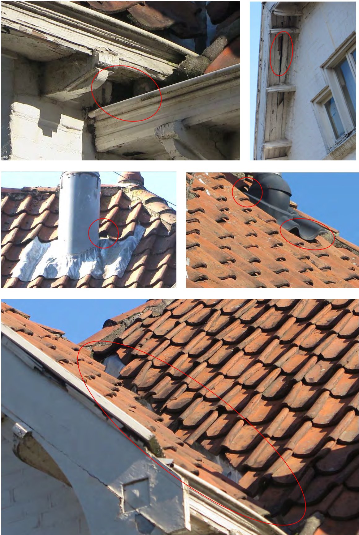
Figuur 2. Potentiele verblijfplaatsen van vleermuizen en gierzwaluwen aan de Tuinstraat 27 Krimpen aan den IJssel.
