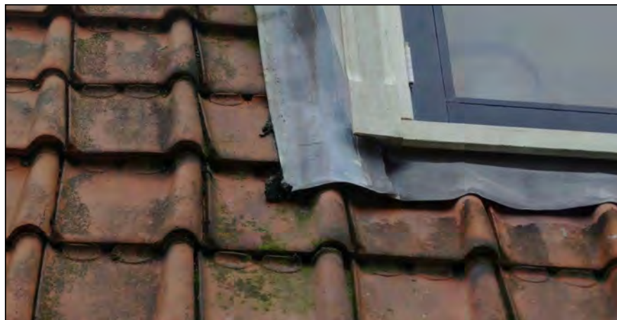
Figuur: op het dak is er op sommige plaatsen ruimte onder de loodslabben waar ruimte is voor vleermuizen om onder te kruipen.
