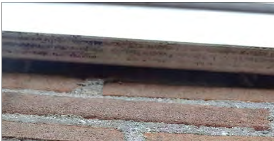
Figuur: bij de aanbouw zijn meerdere plekken waar ruimte is onder de dakrand waar vleermuizen tussen kunnen kruipen. Deze ruimtes zijn te smal voor vogels om in te kruipen.
