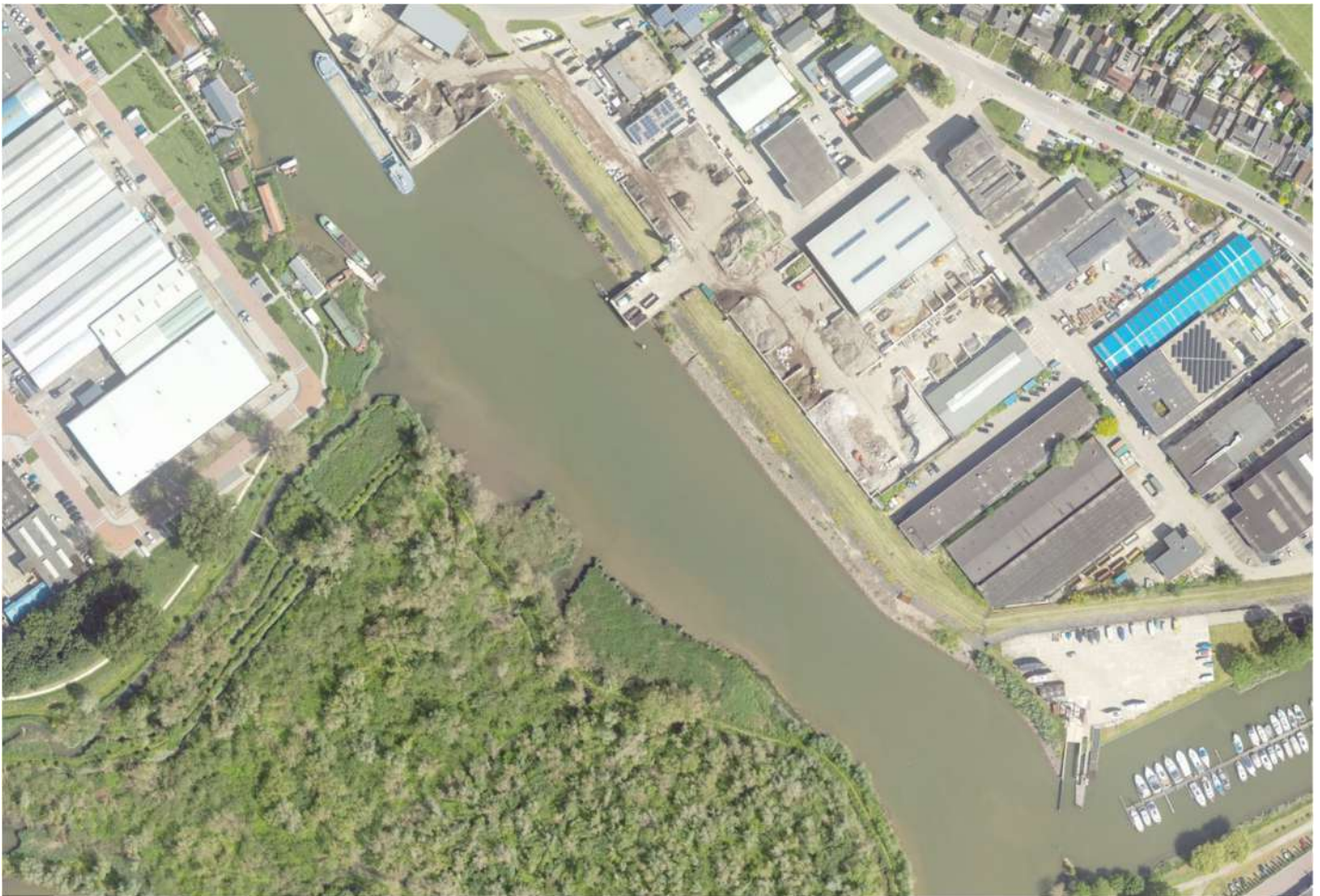
Figuur 2.1 Satellietfoto huidige situatie (Bron: Cyclomedia Streetsmart)
