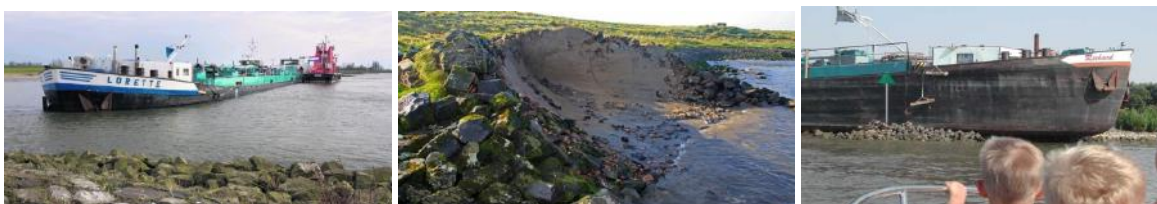
Afbeelding 11: Het verschil in impact bij oeveraanvaring door een geladen of een leeg schip. (Rijkswaterstaat)
