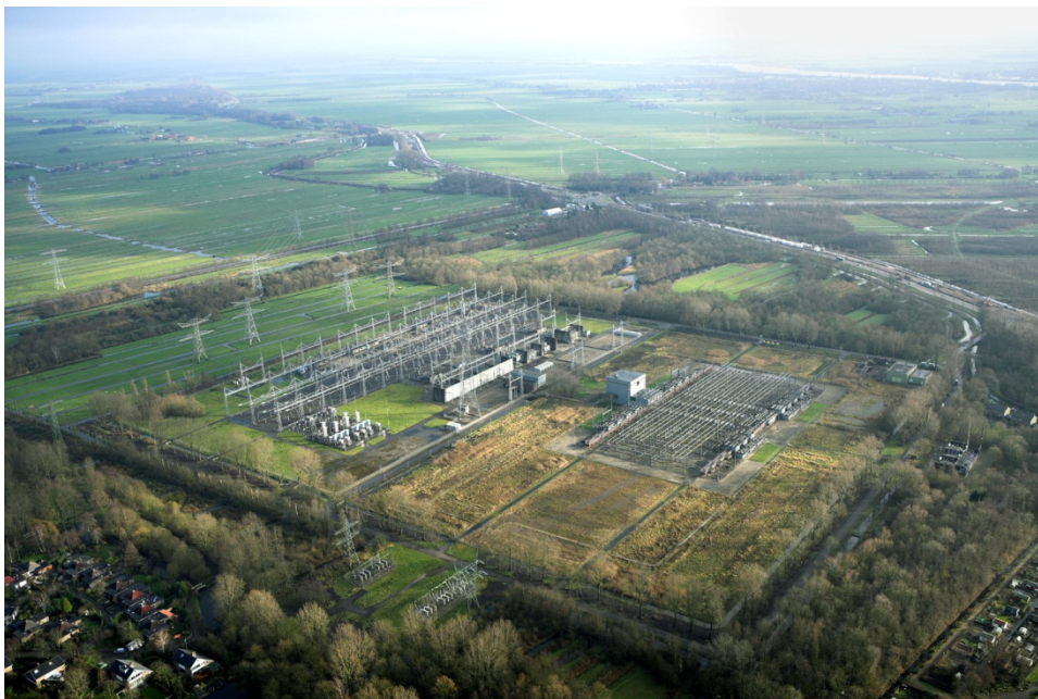
Figuur 14: Luchtfoto transformator- en koppelstation
