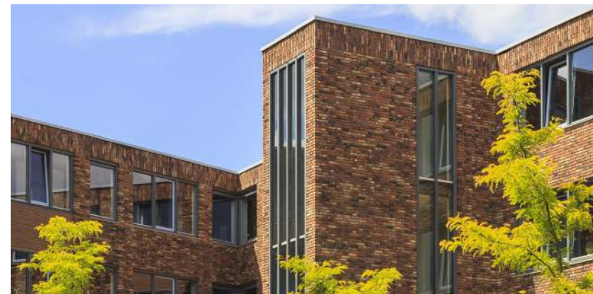
verticale geleiding in de gevel
