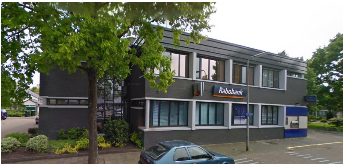
figuur 4: Bestaand gevelbeeld.
