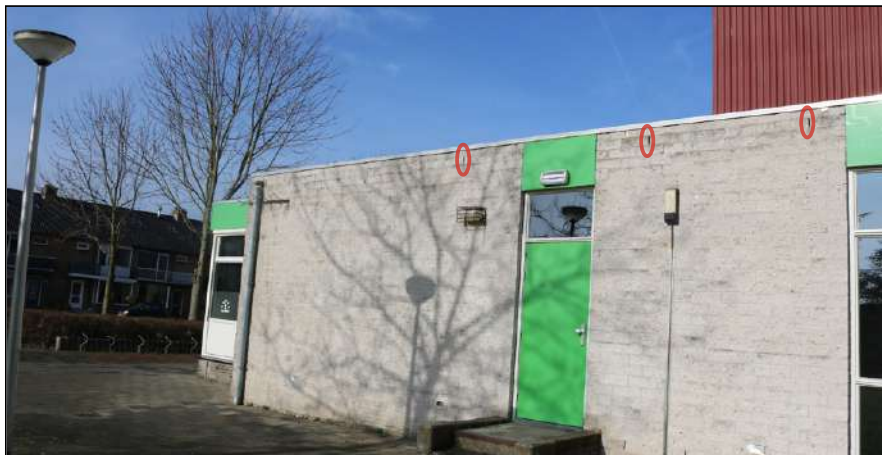
Figuur: er zijn in het bijgebouw meerdere open stootvoegen van 1,5 centimeter aangetroffen. Deze openingen bieden toegang tot een verblijfplaats voor vleermuizen in de spouwmuur. Echter, de verlichting maakt dit ongeschikt.
