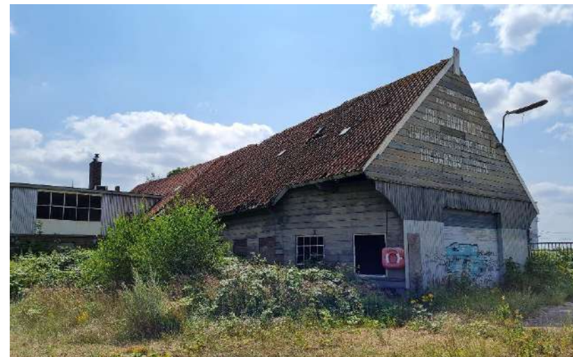
De achtergevel van de grote loods.
