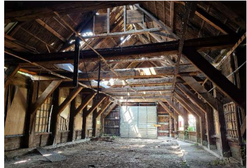
De werkruimte in de grote loods. Deze is nagenoeg geheel leeggehaald. Alleen de imposante draag- en kapconstructie is nog zichtbaar.
