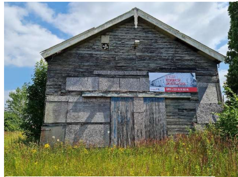
De westgevel aan de zijde van de grote loods is niet oorspronkelijk.
