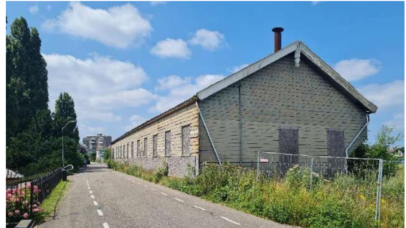
De zuid- en oostgevel van de smederijloods uit 1901.
