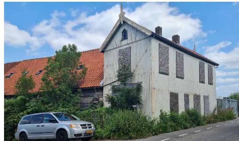
Voorgevel en deel van de linkerzijgevel (west) van de grote loods. Hier is de overgang van Romeinse en oud-hollandse pannen goed te zien. De gevelbekleding gaat grotendeels schuil achter de begroeiing.
