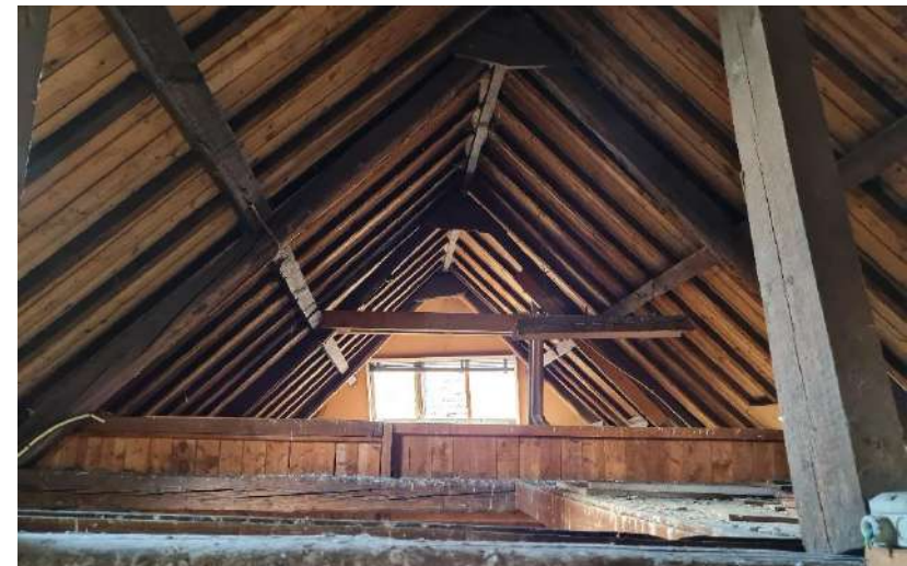
De kap aan de zuidzijde. De dakramen kijken uit op de achtergevel van het aangebouwde kantoorgedeelte.
