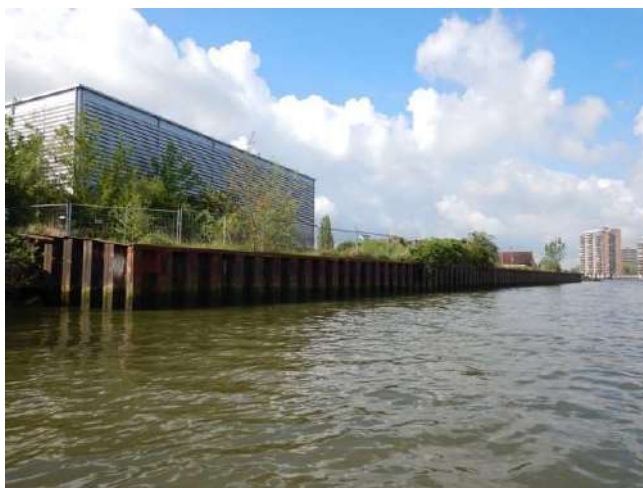
figuur 3.1: Damwand gezien vanaf Hollandsche IJssel
