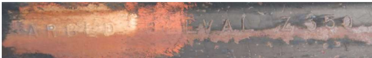
figuur 3.3: Aangetroffen productnaam en typenummer van damwand
