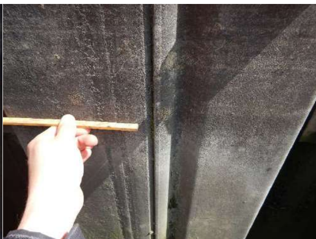
figuur 4.2: Gemeten breedte twee damwandprofielen (1000 mm)
