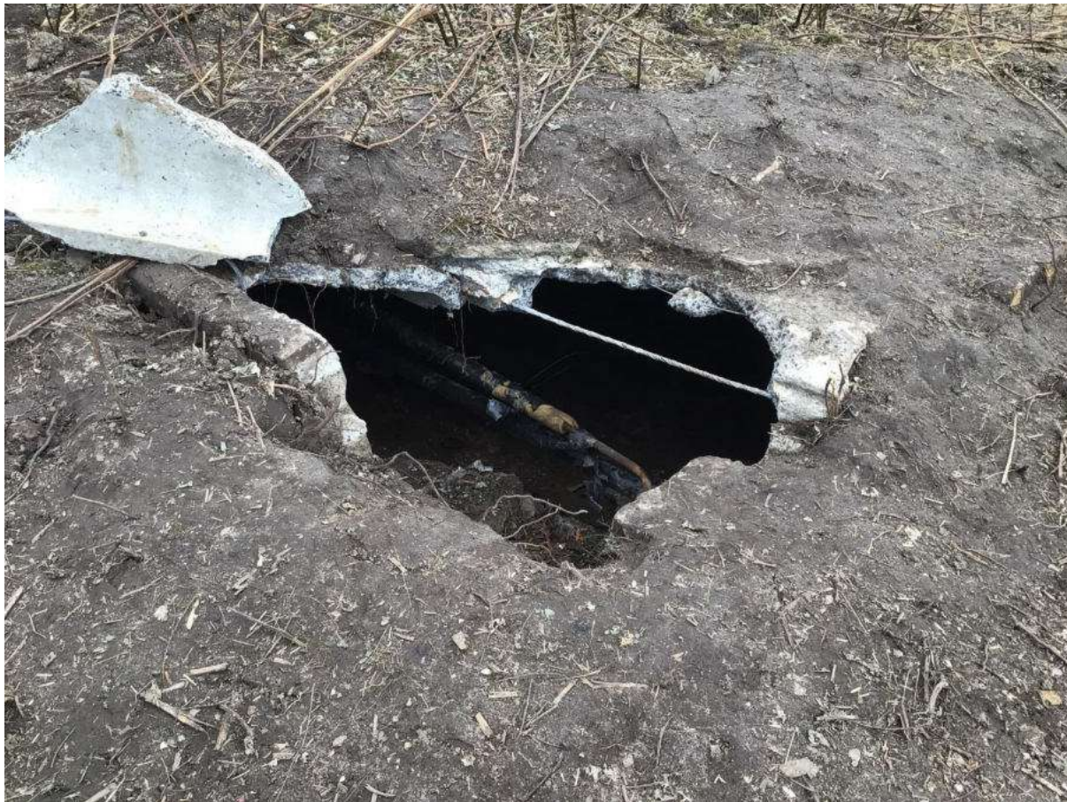
Figuur 14: Opening naar de kruipruimte tussen de funderingen en onder de vloer van het voormalige bedrijfspand tijdens het veldonderzoek.
