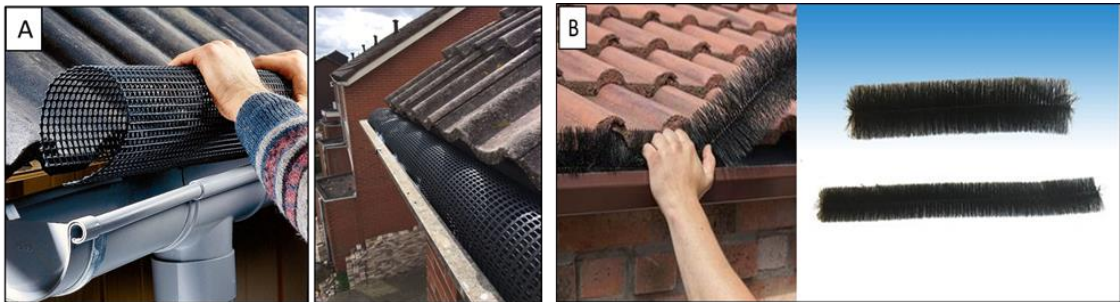
Figuur 2 Om de openingen naar de nestlocatie ongeschikt te maken kan gaas (A) of borstels (B) geplaatst worden.
