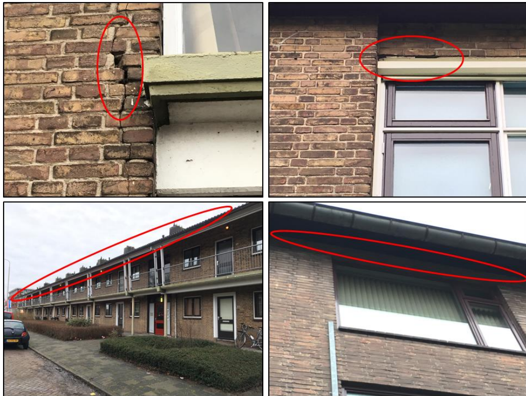
Figuur 3 De woningen bevatten een zadeldak met dakpannen, waarbij de onderste rij dakpannen toegankelijk zijn voor huismus. Derhalve kunnen nestlocaties niet uitgesloten worden. Doordat er een opening tussen de dakgoot en voorgevel aanwezig is, kunnen nestlocaties van gierzwaluw tevens niet uitgesloten worden. In de woningen is er sprake van ontbrekende specie en kierende kantpannen. Vaste rust- en verblijfplaatsen van vleermuizen kunnen hiermee niet uitgesloten worden (bron: Rebergen, 2018).
