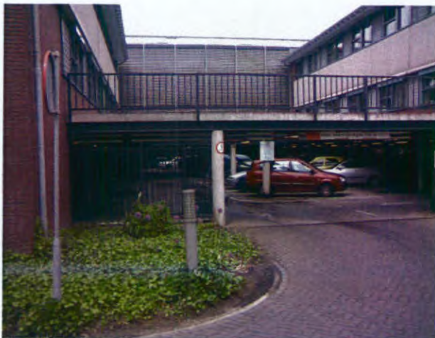
Afbeelding 3_1: Een (mee)gebouwde parkeervoorziening
