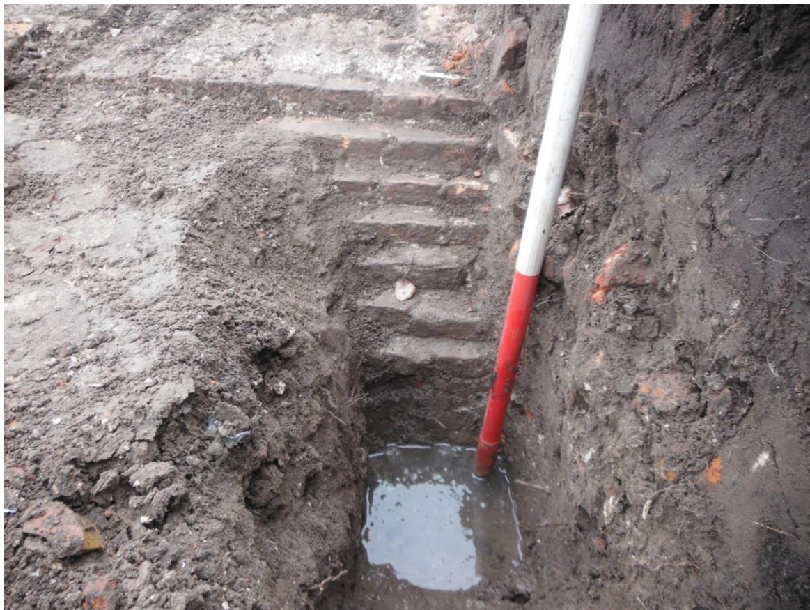
Afbeelding 13 Foto van versnijdingen fundering
