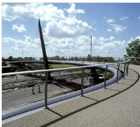
Figuur 3 Referentiebeelden brug...
