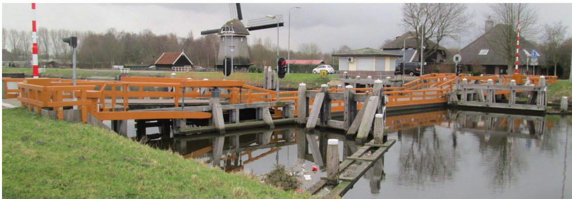
Afbeelding 4.8 Vlotbrug Noord Hollands kanaal bij Koedijk (gerealiseerd in 2011)
