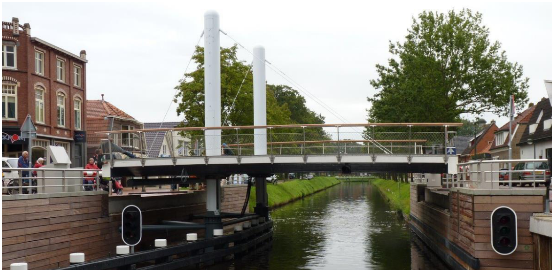
Afbeelding 4.6 Hefbrug Oosterwolde van vezelversterkte kunststof met twee pylonen.
