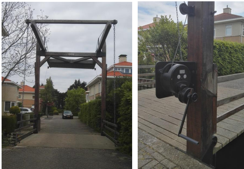
Afbeelding 5.1 Handmatig bediende brug Waterbospark te Rijsbrug gemeente Katwijk
