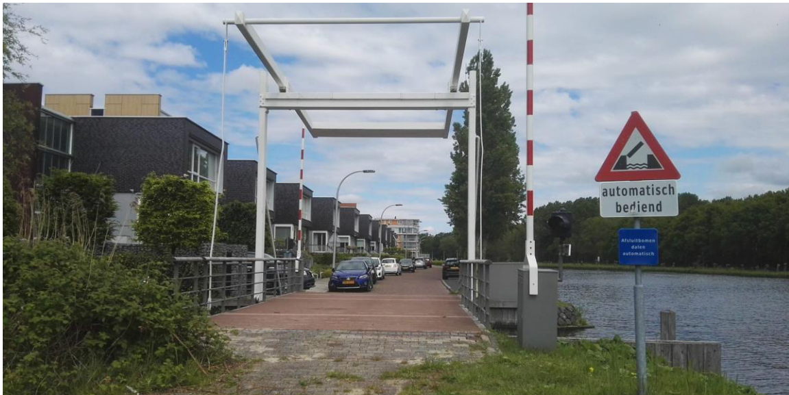
Afbeelding 5.4 Automatisch bediende brug (d.m.v. een afstandsbediening) in de Hofvliet te Voorschoten
