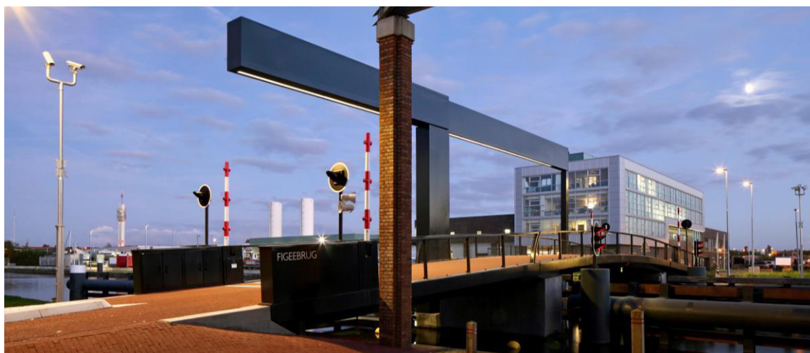
Afbeelding 5.6 Automatisch bediende brug op afstand (door centrale) te Haarlem
