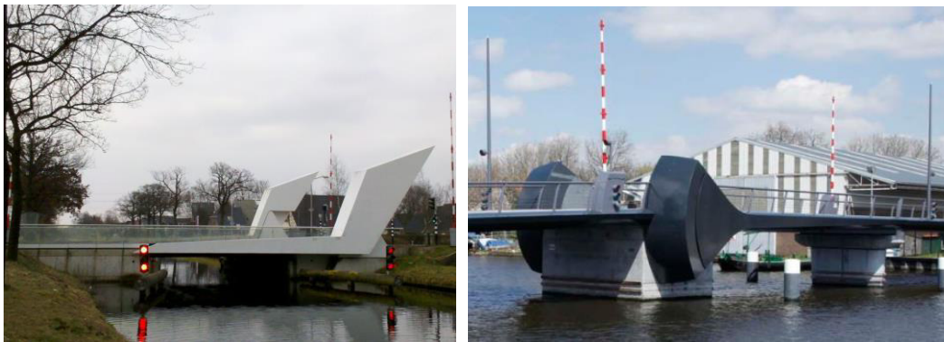
Afbeelding 4.3 Staartbruggen: Kloosterbrug te Assen (links) en de Kadoelenbrug te Amsterdam (rechts)
