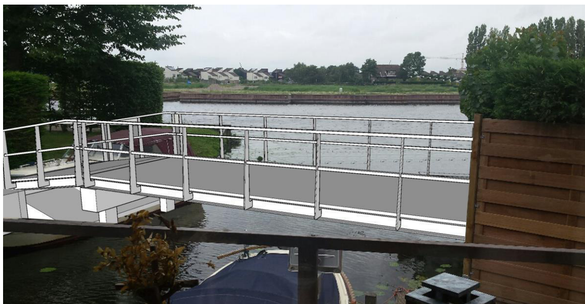
Afbeelding 7.1 Botenpad 29 - zicht op brug vanuit woonkamer woonboot (1,20m)
