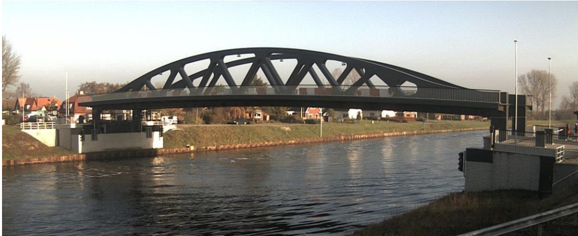
Afbeelding 4.7 Tafelbrug Zuidhorn (gerealiseerd 2017)
