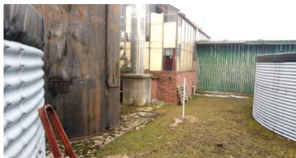
Foto 5: Zicht op ketelgebouw/verwarmingsruimte en de oude stookolietank, links en rechts water bassins
