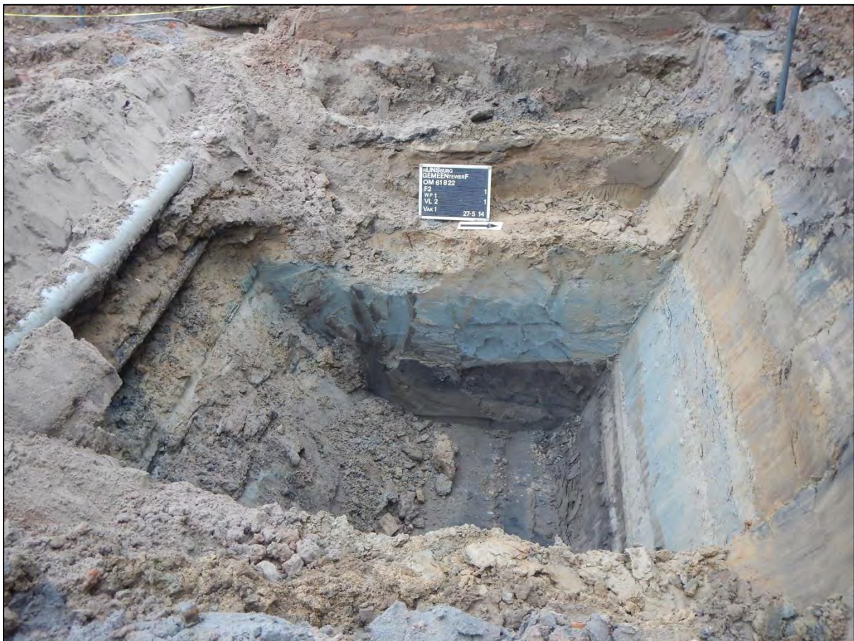
Figuur 2: Door de proefsleuven liepen enkele kabels en leidingen.
