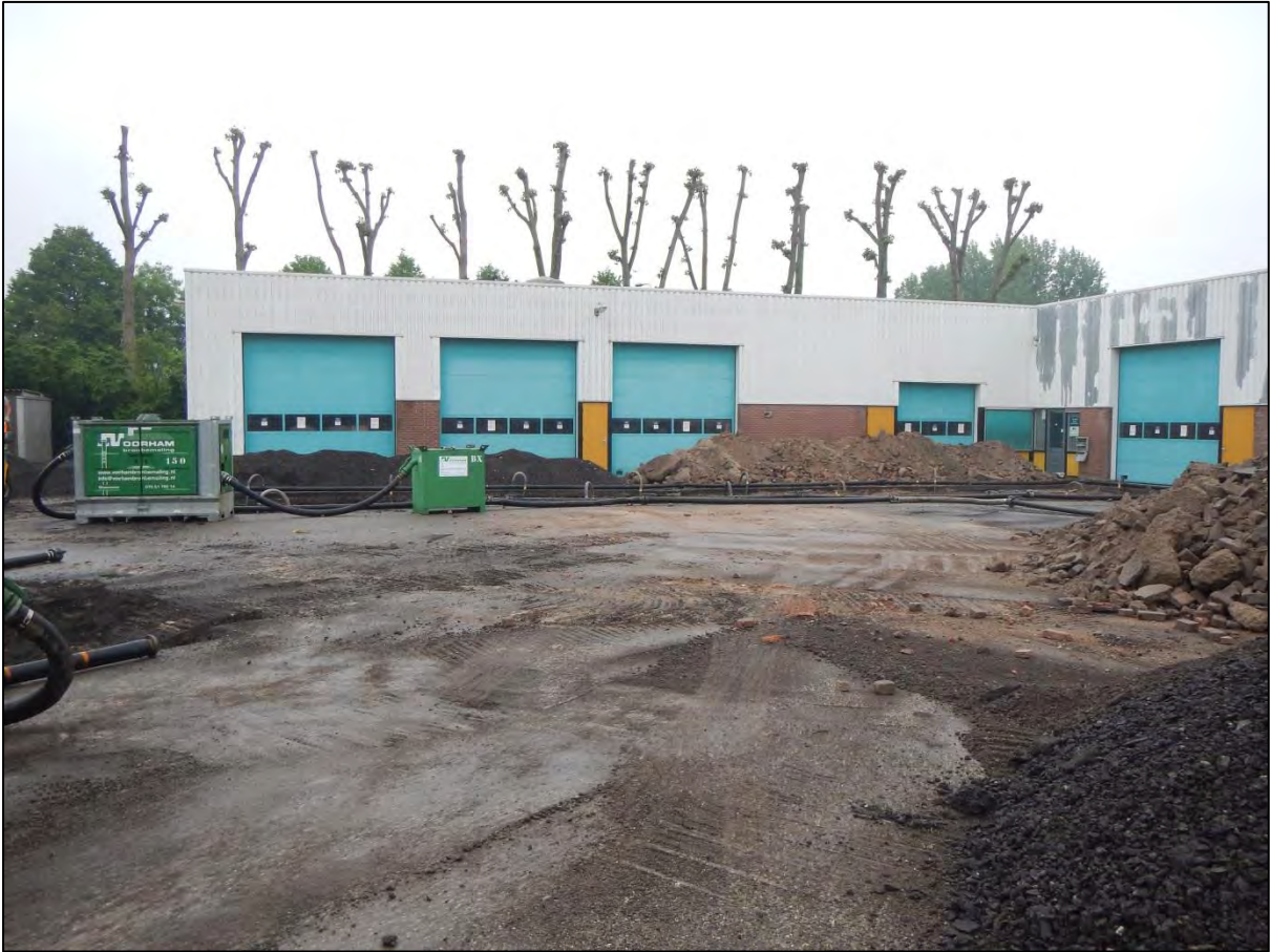
Figuur 1: Het plangebied voorafgaand aan het veldwerk. Het asfalt is verwijderd en de bronbemaling geplaatst
