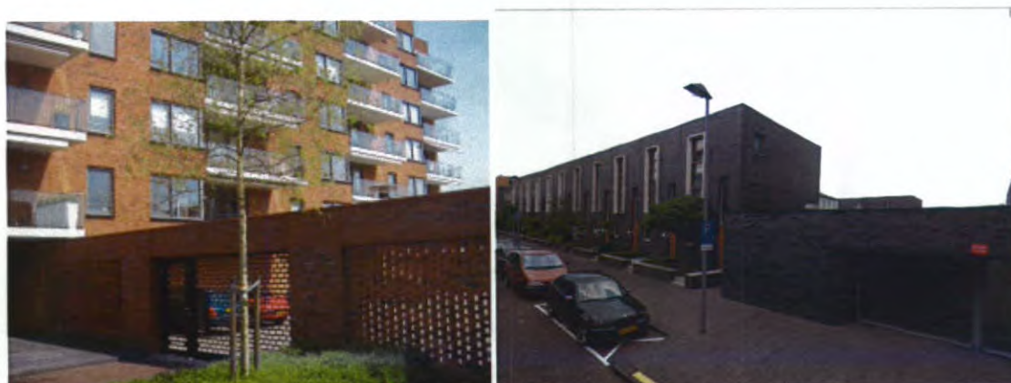
Afbeelding 3_5: voorbeelden van afgesloten parkeerterrein in de architectuur van het pand.
