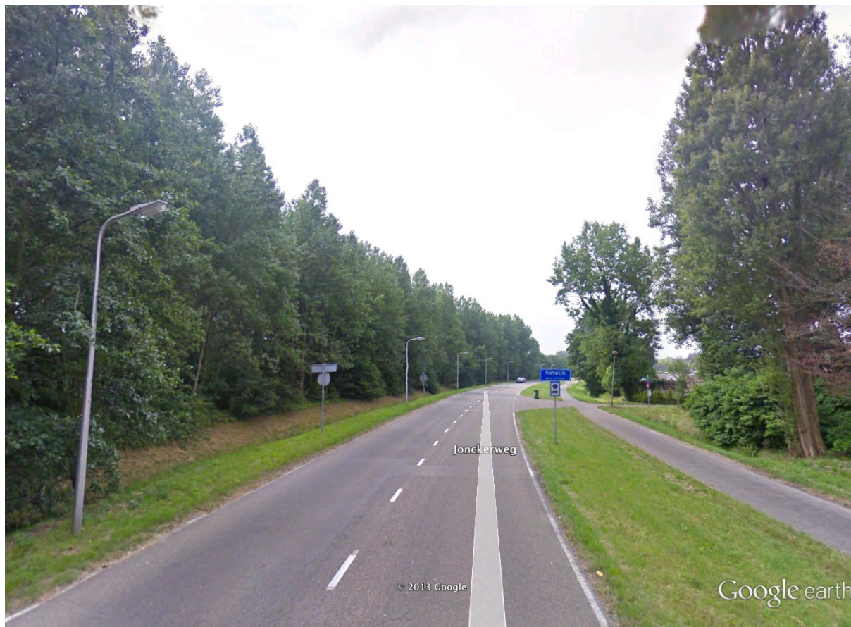
Afbeelding 4: Oversteekplaats Jonckerweg thv Zuideinde, met rechts de eerste bomen van de te verwijderen bomenrij
