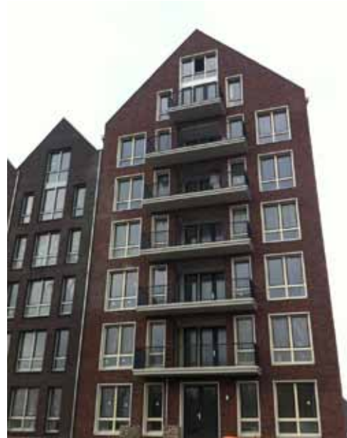
verticalisme in massa, (dak)vorm, positie balkons en gevelopeningen
