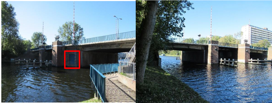
Figuur 4.3: De oostelijke kant van de brug over de Uitwateringkanaal. De rode omranding weergeeft een luik waarachter een ruimte aanwezig is die mogelijk geschikt is als verblijfplaats voor vleermuizen.
