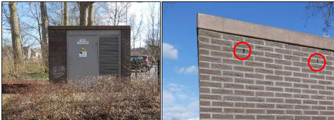
Figuur 13: Het transformatorhuis welke naast het buurtcentrum "De Schelp" staat. Links het vooraanzicht, rechts de openstootvoegen aan een van de zijdes. Beschermde soorten worden hier niet verwacht.
