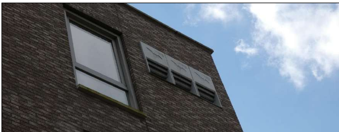
Figuur 16: Ingebouwde vleermuiskasten aan de Hoorneslaan, gebouwbewonende vleermuizen kunnen hier niet uitgesloten worden. Deze flatgebouwen staan binnen de invloedssfeer van werkzaamheden.
