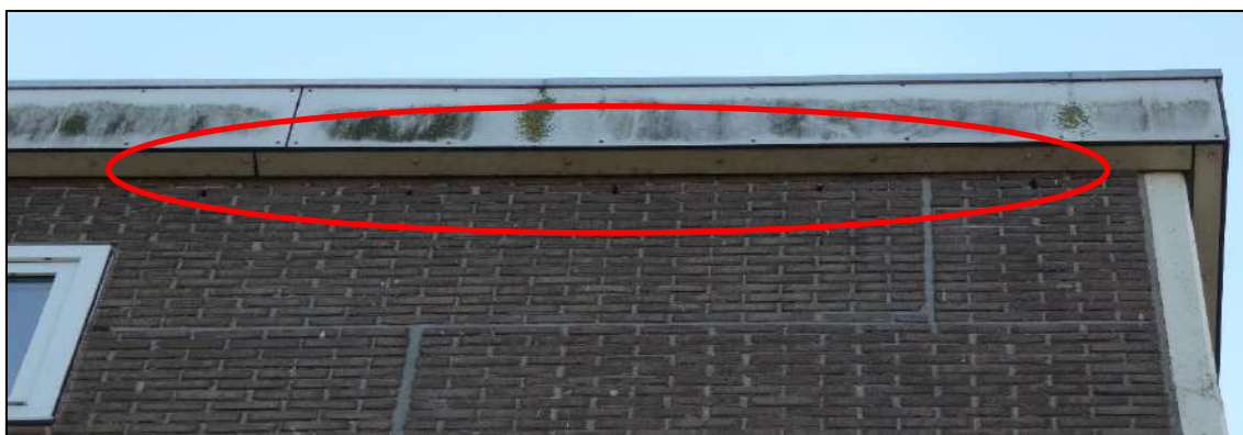
Figuur 10: Openstootvoegen helemaal aan de bovenzijde rondom de vijf flatgebouwen. Potentie voor gebouwbewonende vleermuizen.
