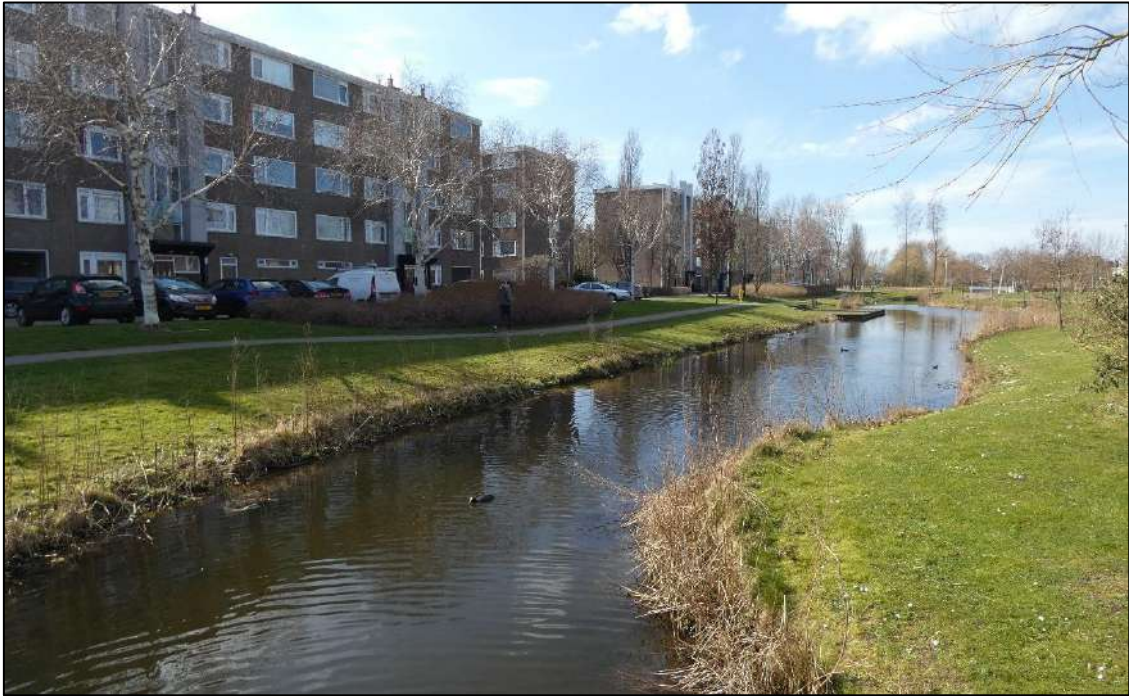
Figuur 22: Sloop aan de noordzijde van het plangebied, met op de achtergrond de flatgebouwen van het plangebied.
