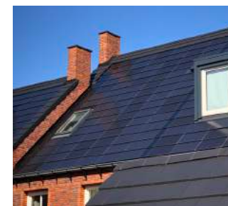
Zonnepanelen geïntegreerd in het dakvlak
