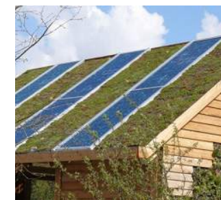
Zonnepanelen geïntegreerd in het dakvlak
