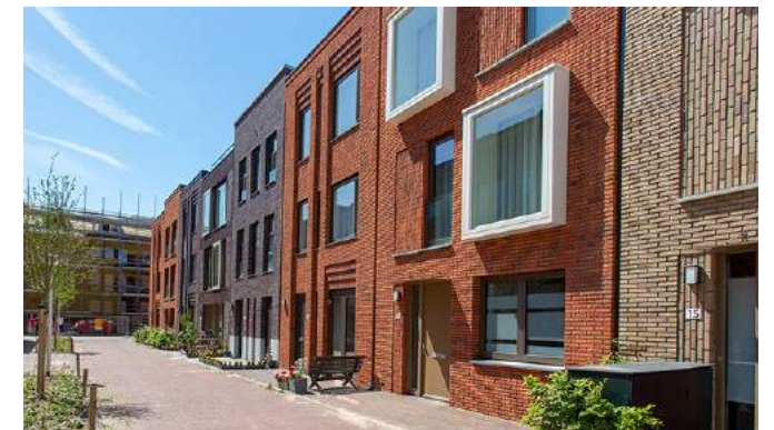
Diepe negges en plasticiteit in gevels ter plaats van overgangen privé-openbaar
