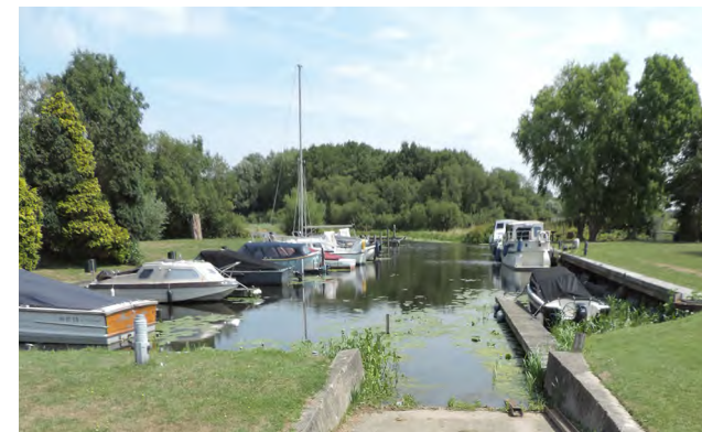
Insteekhaven ter hoogte van het gemaal
