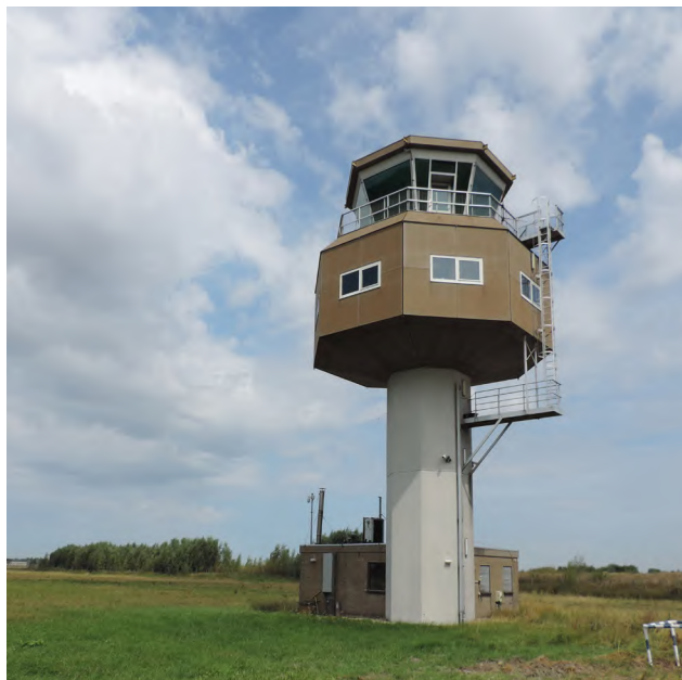
Bestaande verkeerstoren - voormalig Marine Vliegveld Valkenburg
