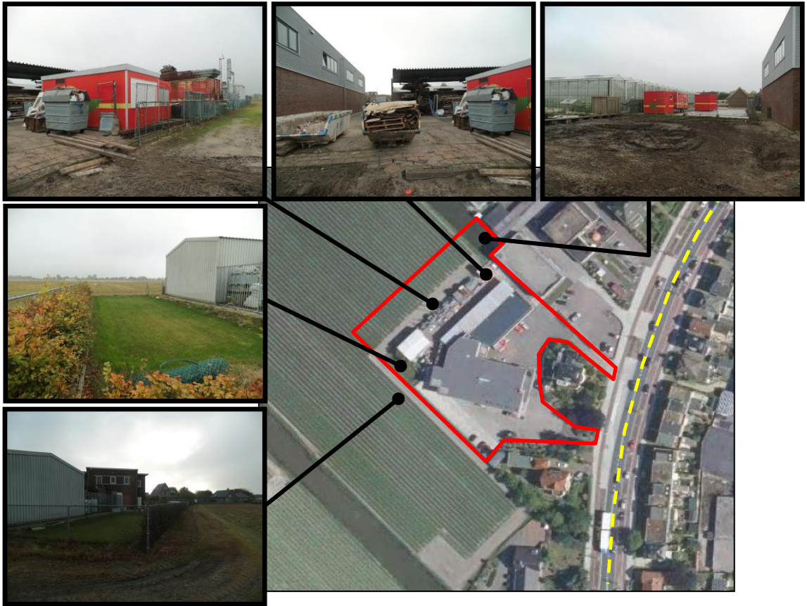
Afbeeldingen: de foto's tonen de bestaande situatie ter plaatse van de randen van het projectgebied. Het projectgebied wordt in de bestaande situatie grotendeels begrensd door een transparant en metalen hekwerk dat deels in een slechte staat van onderhoud verkeert. De bedrijfskavel sluit aan op een strook grond dat voor agrarische doeleinden in gebruik is geweest.
