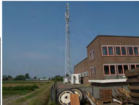
KPN gebouw met zendmast telefonie.
