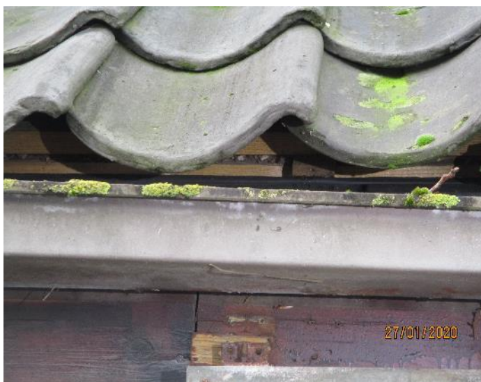
Figuur 4 Houten balken onder dakpannen van de kleine opslagschuur (gebouw B).
