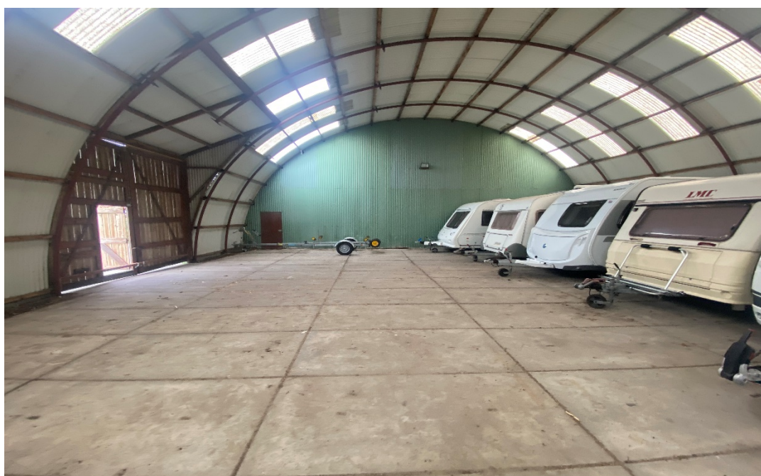
Foto 4: binnenkant zuidelijk gelegen loods, genomen vanuit oostelijke richting.
