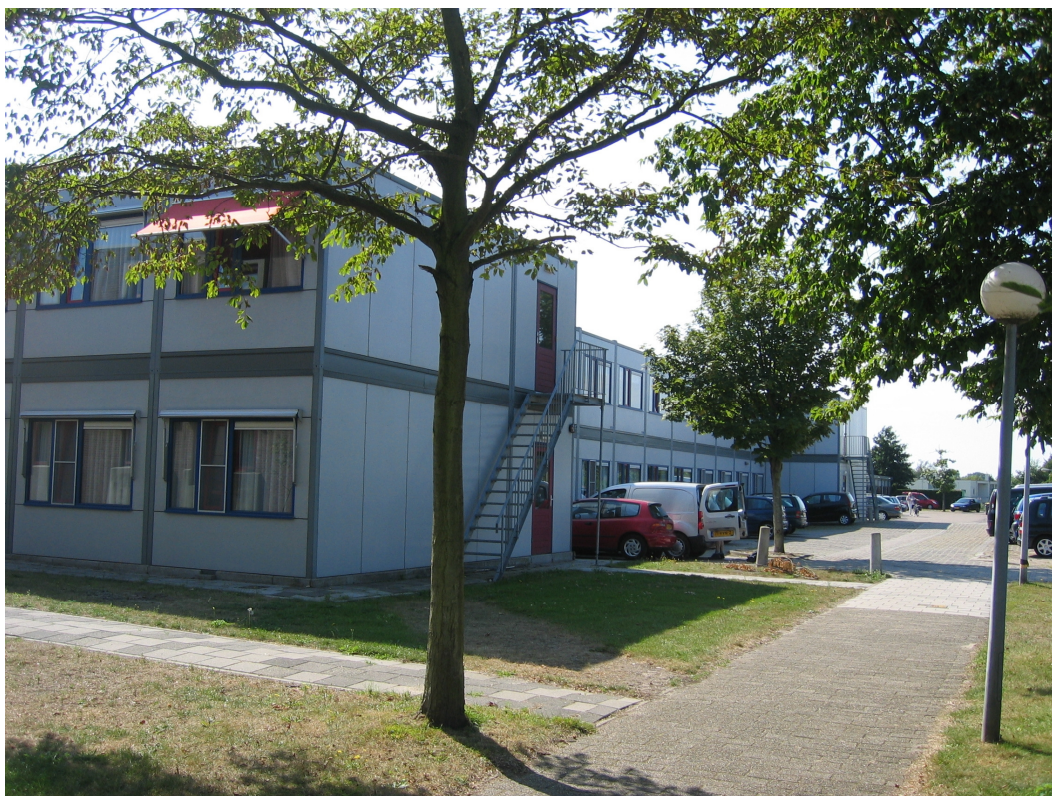
Afb. 6 Foto van het plangebied en het noodgebouw.
