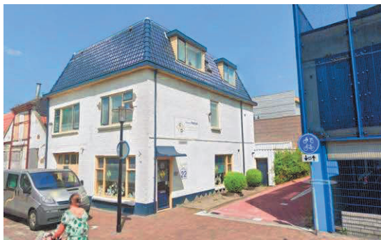
afb.7 Huidige situatie, gevelbeeld Molenstraat
