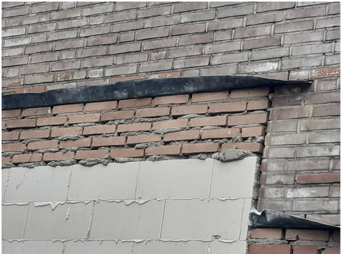
Ruw metselwerk zijmuur Van den Endelaan 68 achter Molenstraat 22
