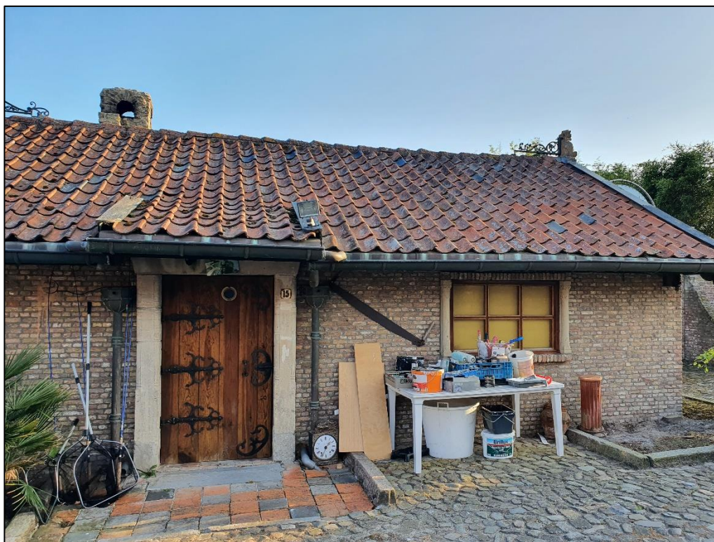
Figuur 1 Het te saneren gebouw op de planlocatie.
