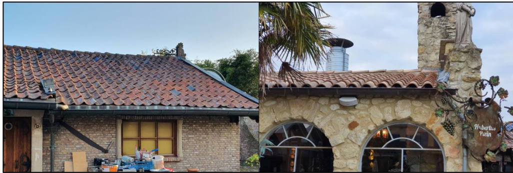
Figuur 3 Visuele ondersteuning van het pannendak van het te saneren gebouw op de planlocatie.
