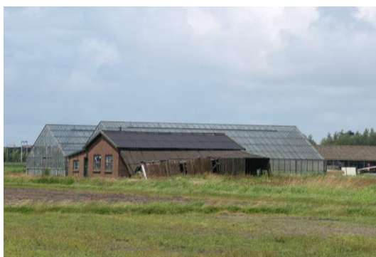
Figuur 17; te saneren opstallen IV
