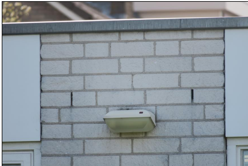
Figuur 4.3. Spouwstenen die mogelijk toegang bieden tot verblijfplaatsen van vleermuizen in de spouw.
