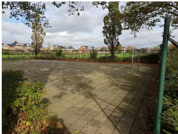
Fotonummer: 8 Omschrijving: locatie overzicht
