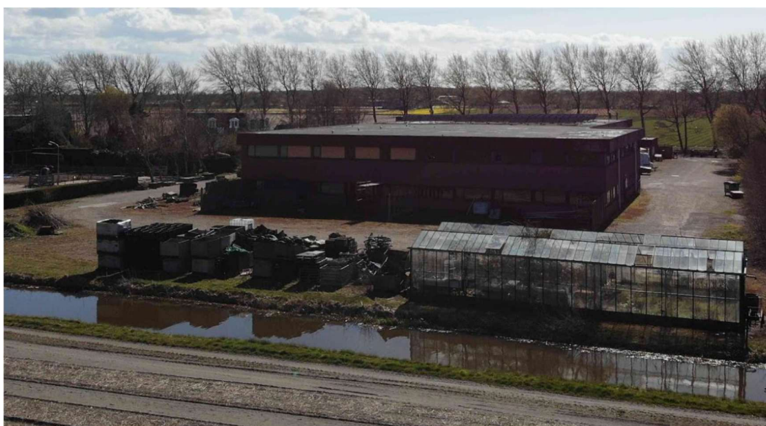
Zicht op het bedrijfsperceel vanaf naast gelegen bollenveld.
