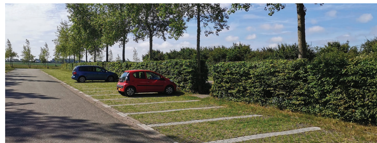
Duurzaam alternatief van grasbetonsteen met uitstapstroken
