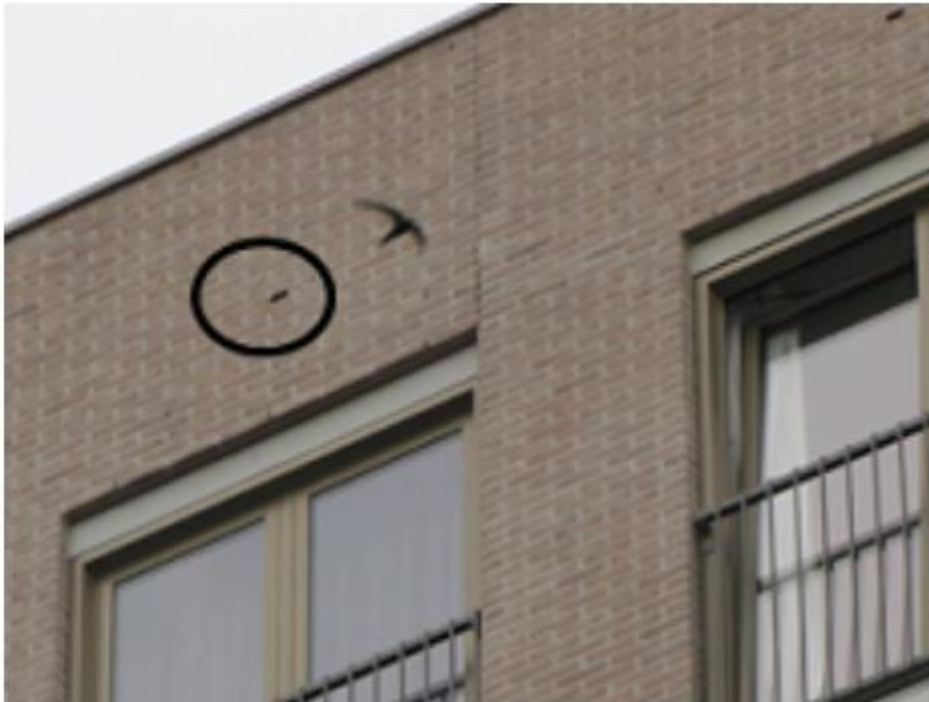
Boven in de geplande nieuwbouw kunnen deze vrijwel onzichtbare gierzwaluwstenen worden ingemetseld.
