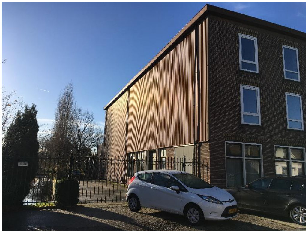
Figuur 2 Het plangebied betreft een bedrijfsp perceel dat in het verleden in gebruik geweest is t.b.v. bollenteelt. Op het perceel is een zogenaamde bollenschuur met diverse uitbouwen gesitueerd.
