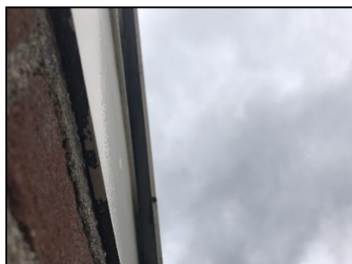
Figuur 9. Detailfoto van de rand van de daklijst die strak aansluit op de gevel.
