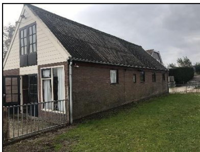
Figuur 3. Overzichtsfoto van de noordelijke en westelijke gevel van de stal.
