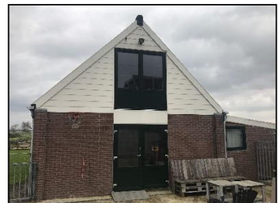
Figuur 5. Zuidelijke gevel van de stal.
