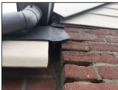
Figuur 10. Detailfoto van kleine wegkruipruimte in de noordoostelijke hoek van de stal.
