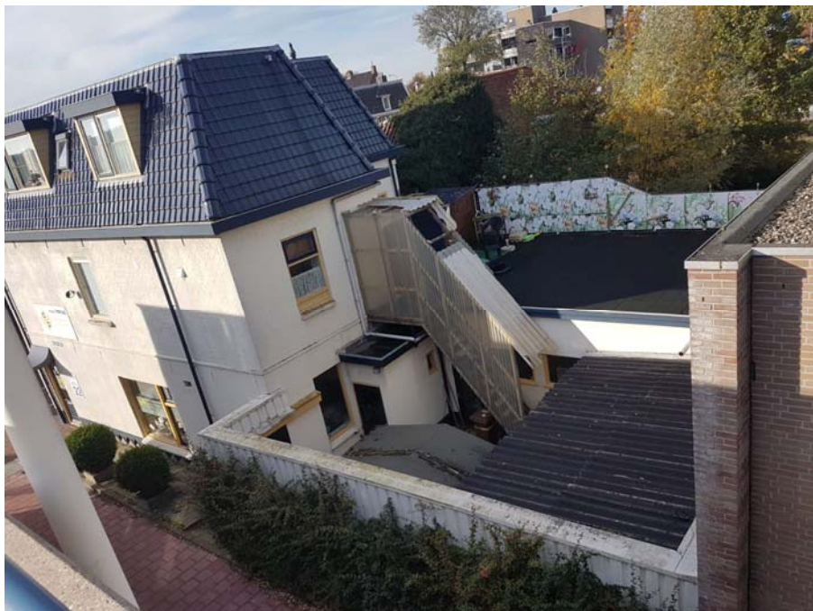
afb.14 Overzicht achterzijde met bijgebouwen
