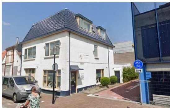
afb.4 Huidige situatie, gevelbeeld Molenstraat
