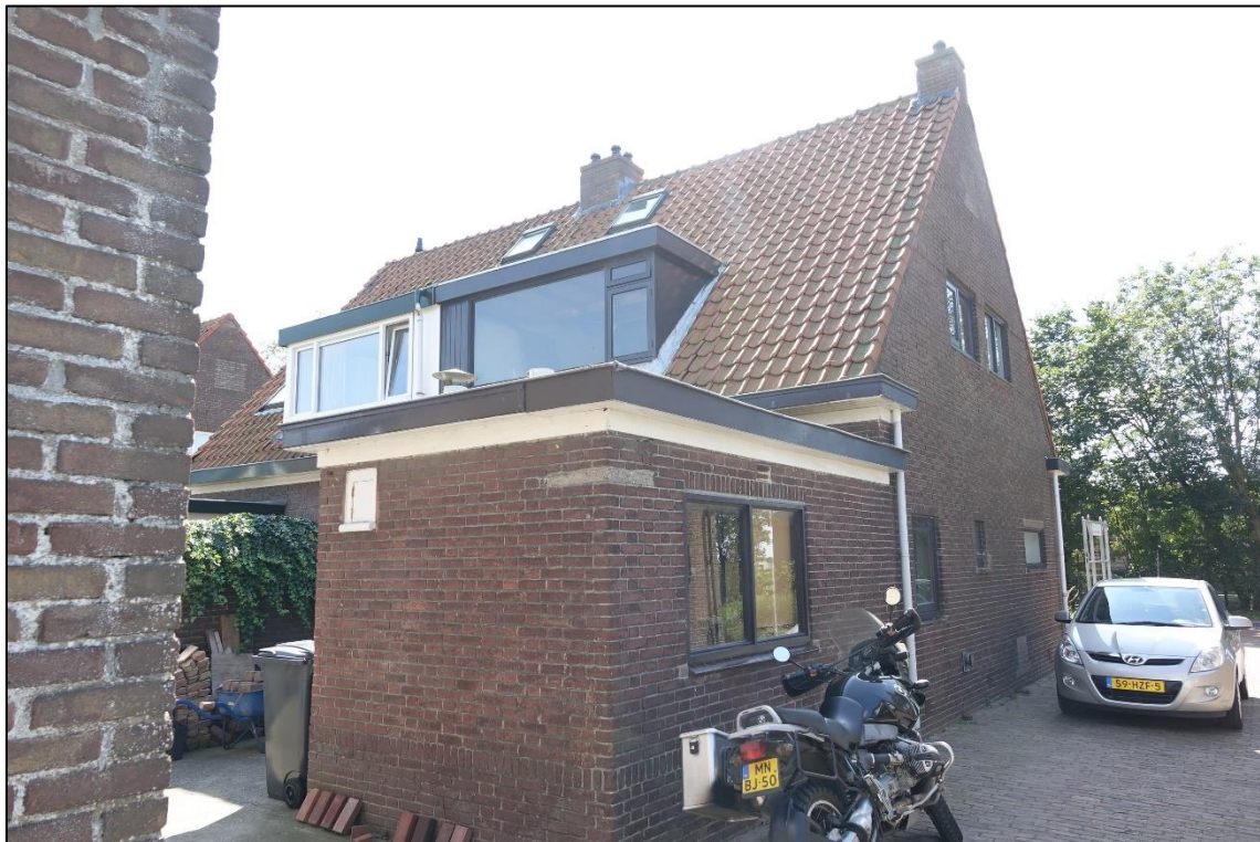
Figuur 2: Achterzijde van de twee onder één kapwoning waar de werkzaamheden zullen plaatsvinden.
