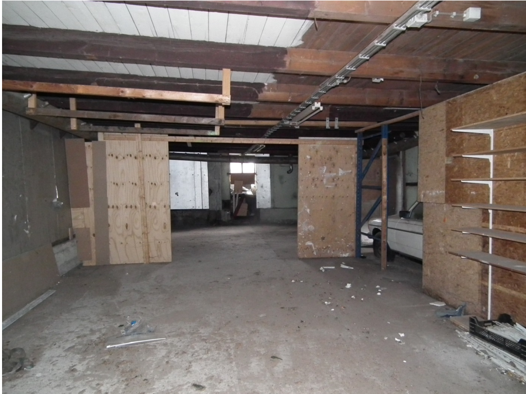
Figuur 3 De schuur is voormalig in gebruik geweest als opslag van bloembollen. In de huidige situatie worden enkele auto's en overige spullen opgeslagen.
