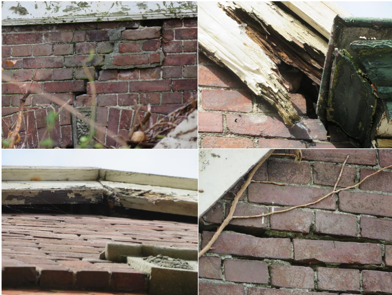
Detailfoto's mogelijke verblijfplaatsen vleermuizen in het woonhuis in het plangebied.
