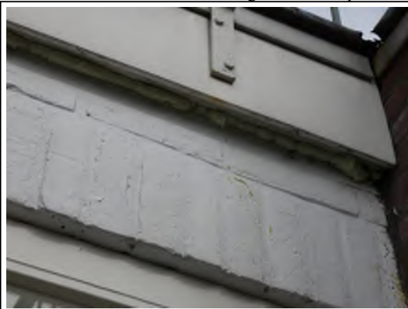
Foto 6 ruimte onder rand dichtgemaakt met purschuim
