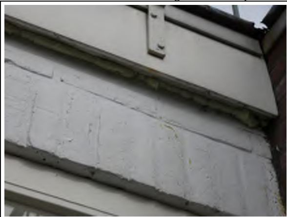
Foto 6 ruimte onder rand dichtgemaakt met purschuim
