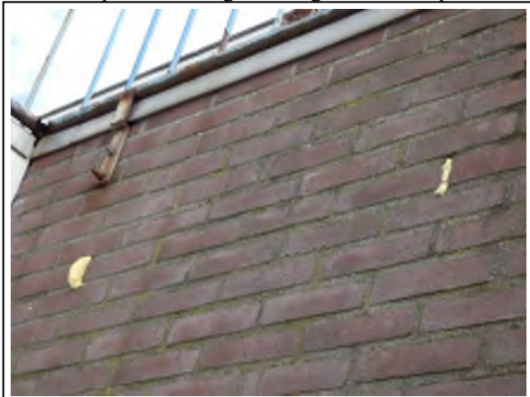
Foto 5 open stootvoegen dichtgemaakt met purschuim
