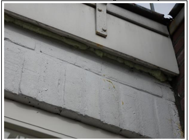
Foto 6 ruimte onder rand dichtgemaakt met purschuim
