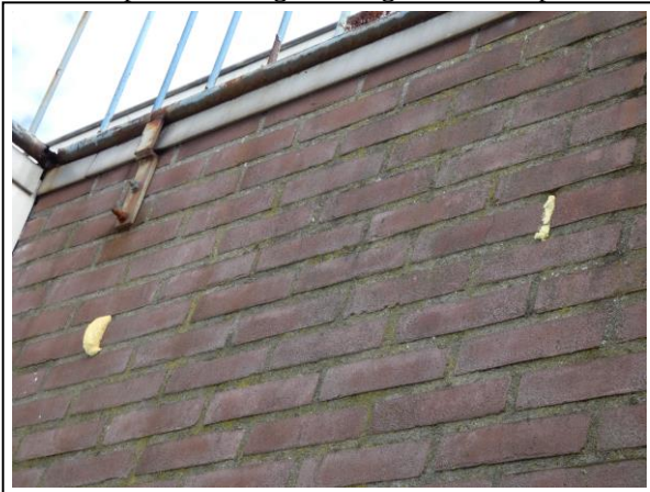
Foto 5 open stootvoegen dichtgemaakt met purschuim
