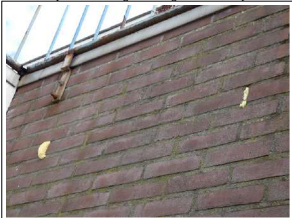
Foto 5 open stootvoegen dichtgemaakt met purschuim
